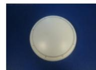
**Комбинированные тепло-дымовые датчики** установлены в электрических комнатах.
