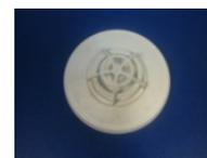
**Оптические (дымовые) датчики** установлены в каждом офисе и на общих площадях здания. Оптические (дымовые) датчики срабатывают в случае задымления.
