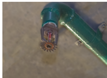
Спринклер в гараже
